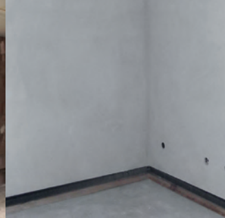
verputzte Wand mit Heizregister
