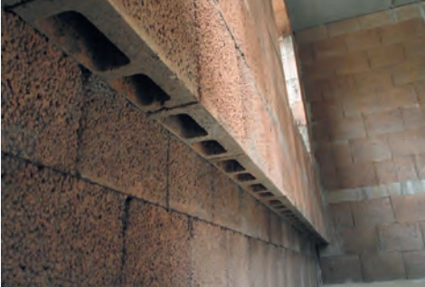
vertikale Kanäle in der Hypokaustensteinwand
