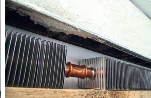
installierte Netzrohre unterhalb der Luftkanäle
